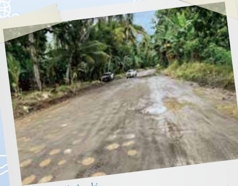
Yamamoto Takaaki 降雨により路面が軟弱化、車両の安定した通行を阻む
