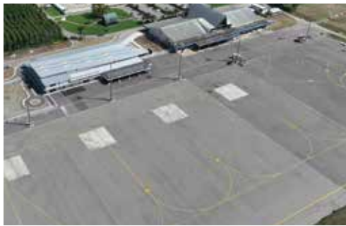
ホニアラ国際空港国際線ターミナルエリア全景。国際線エプロンを4倍以上に拡張し、国際線と国内線の両方に対応する駐機体制を実現。
